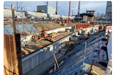
Bauzwischenzustand der Unterführung am Luther Weg in Wunstorf
