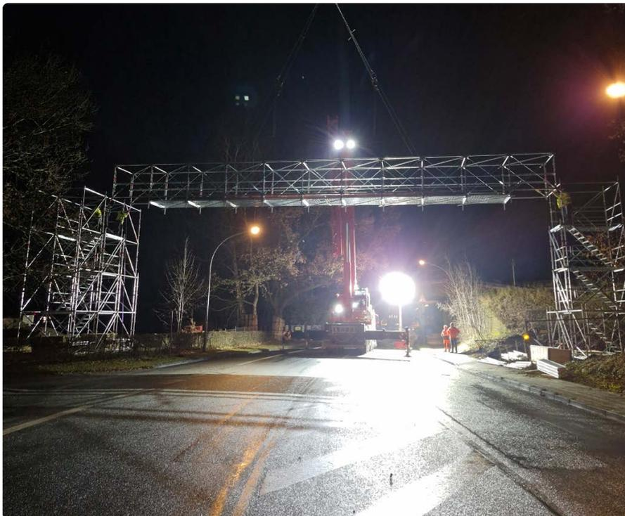
Bauarbeiten bei Nacht: Die Kabelhilfsbrücke entsteht.
