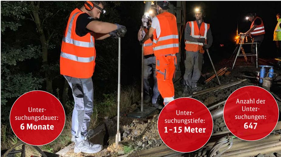
378 Bohrsondierungen, vier schwere Rammsondierungen und fast 70 Schürfe im Gleisbereich sind Teil der Baugrunduntersuchungen. Hinzu kommen fast 200 sogenannte Doppelaufschlüsse, bei denen – wie hier im Bild zu sehen – sowohl eine Bohrsondierung als auch eine schwere Rammsondierung durchgeführt wird. Durch den Einsatz von kleinen, lärmgedämpften Untersuchungsgeräten kann für die Anwohner eine Geräuschminderung erreicht werden.
