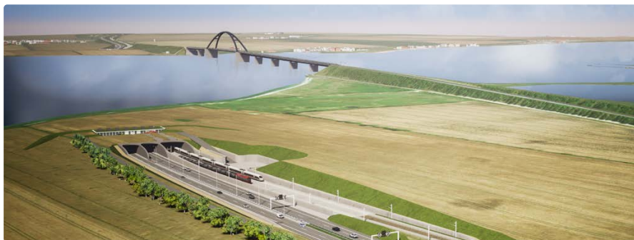
Ein neuer Absenktunnel für den Schienen- und Straßenverkehr verbindet in Zukunft die Insel Fehmarn mit dem Festland. Die Fehmarnsundbrücke bleibt für Fußgänger, Radfahrer und den langsamen – zum Beispiel landwirtschaftlichen – Straßenverkehr erhalten.
